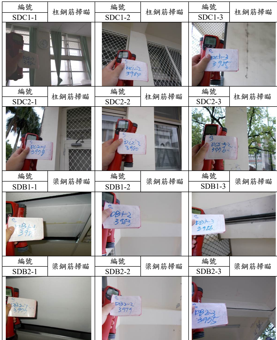
3.4.2 鋼筋排列檢測成果彙整 (1) 各樓層柱構件檢測位置及結果
